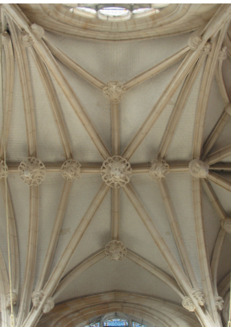
Voûte du chœur
